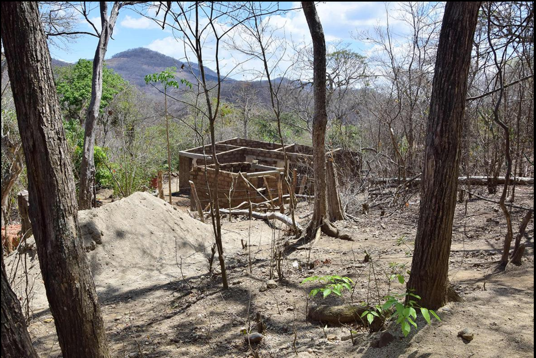
Fase de construcción
