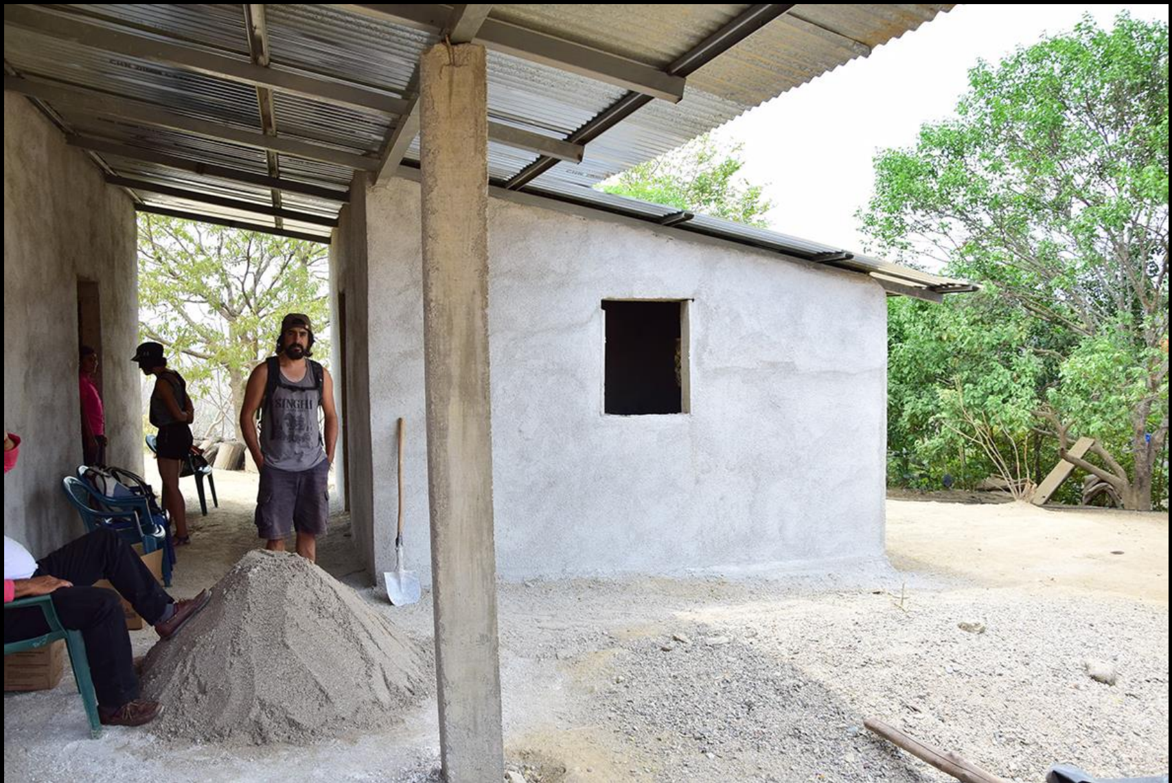
Fase de construcción
