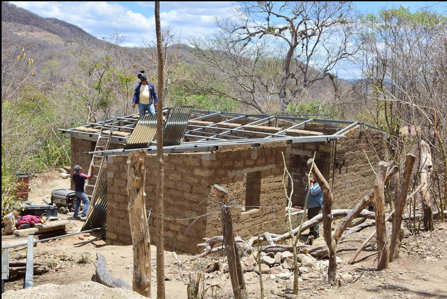
Fase construcción, techando con base de perlines.
