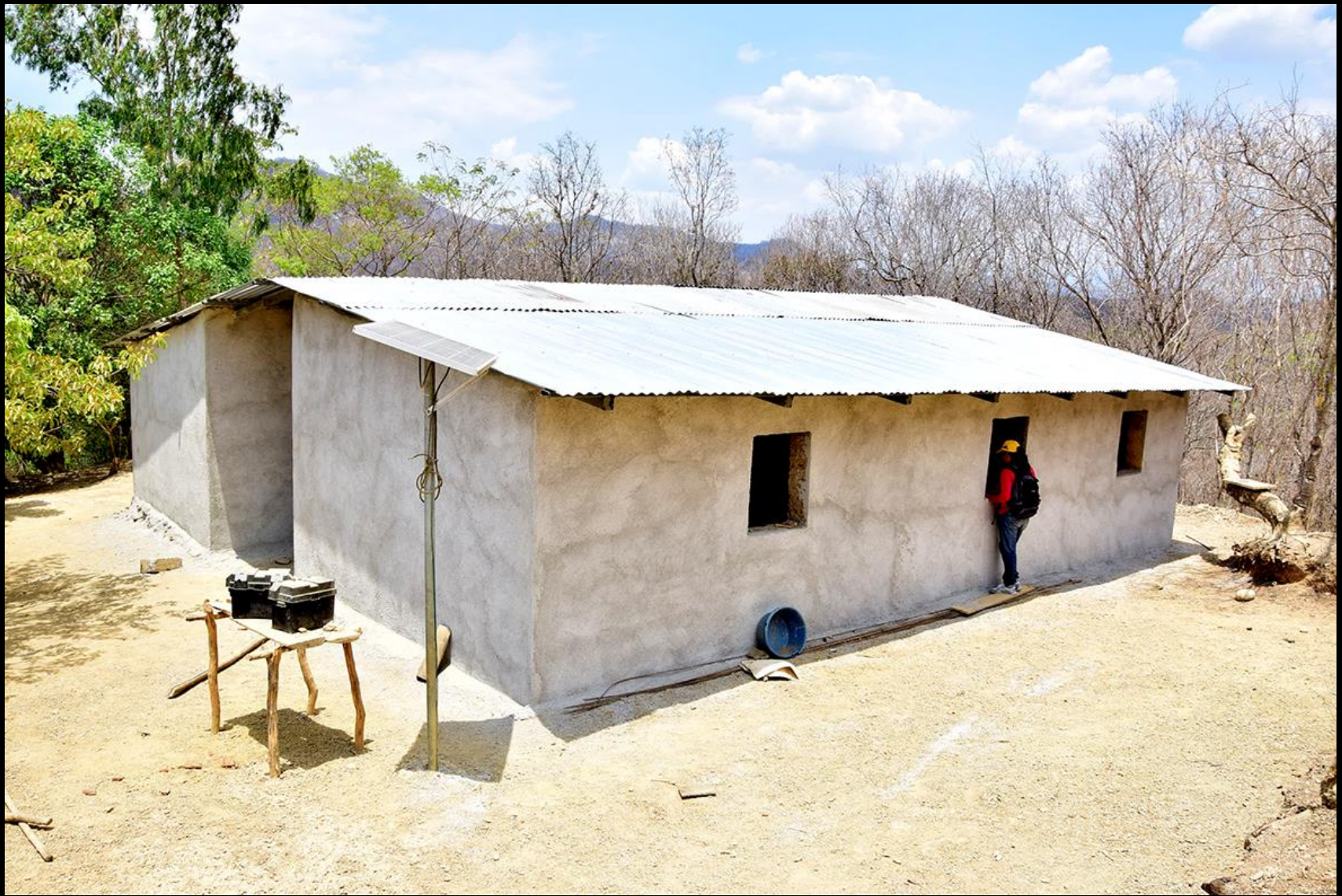
Fase de construcción
