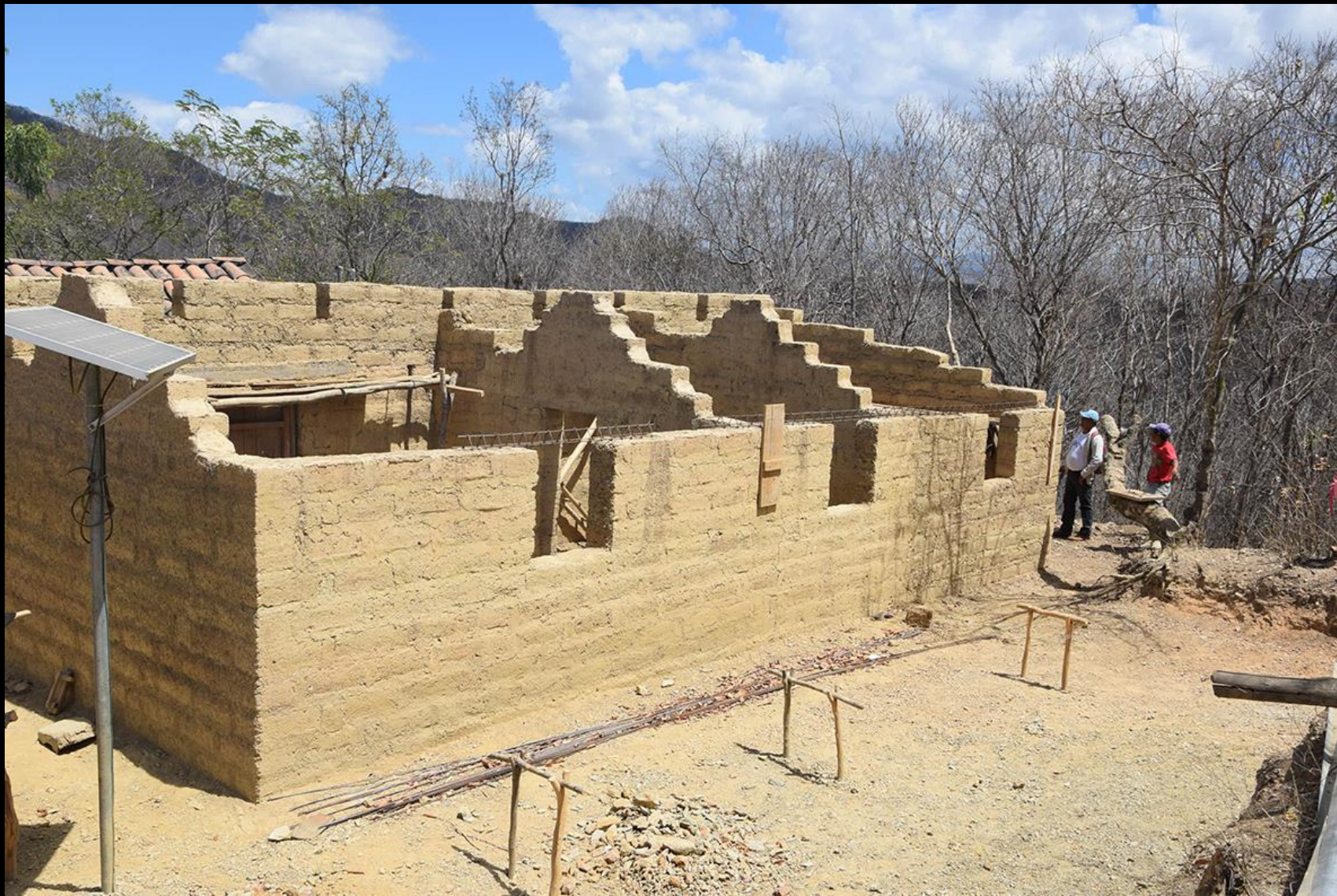
Fase de construcción
